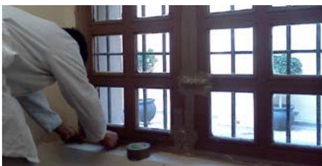
Sellado para evitar fuga de gases y sea más efectivo el tratamiento
